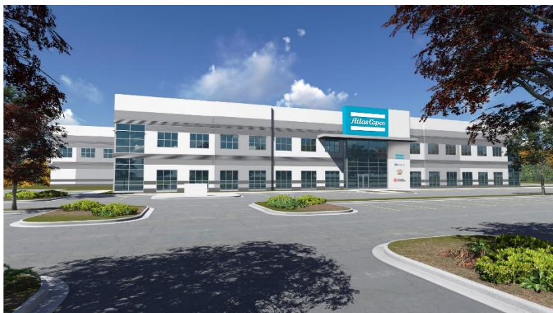
Den nya fabriken i Rock Hill, South Carolina, USA
