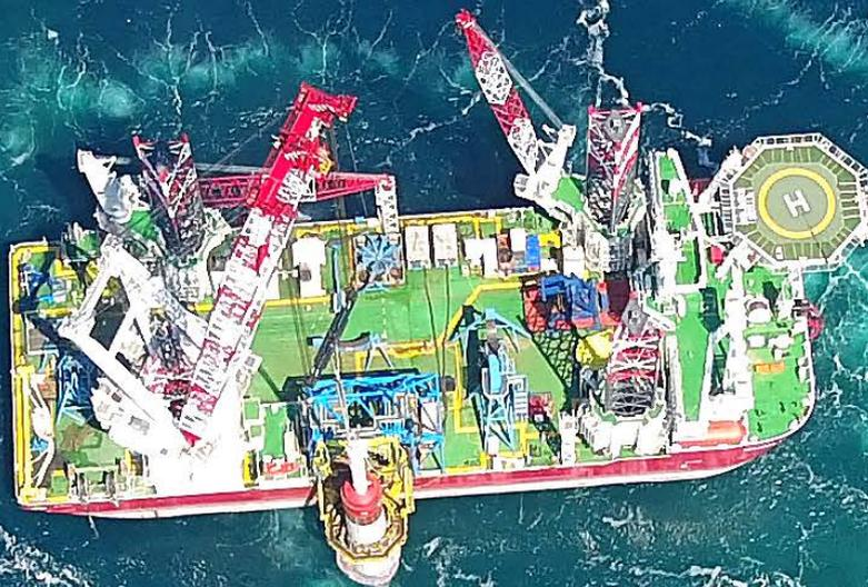
Beim Bau von Offshore-Windkraftwerken muss die Unterwasserwelt vor Störungen durch Lärm und Schwingungen geschützt werden. Die Lösung besteht darin, einen Schutzvorhang aus kleinen Luftblasen zu erzeugen. Mithilfe eines Atlas Copco-Kompressors wird Luft durch einen perforierten Schlauch gedrückt, wodurch ein Blasenring um die Baustelle herum entsteht.
