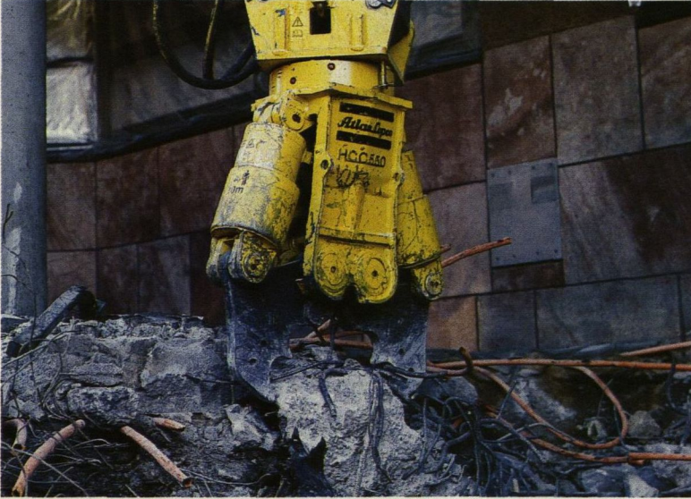
Demoleringsutrustningen finkrossar betongen så att stål och betong lätt kan separeras och återanvändas.
