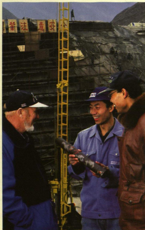
Förstärkningsborrning av dammar för kraftverk pågår på många ställen i Kina.
