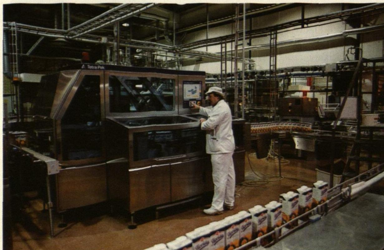
Elektroniska styrssystem från Atlas Copco Controls i en av Tetra Paks senaste förpackningsmaskiner.
