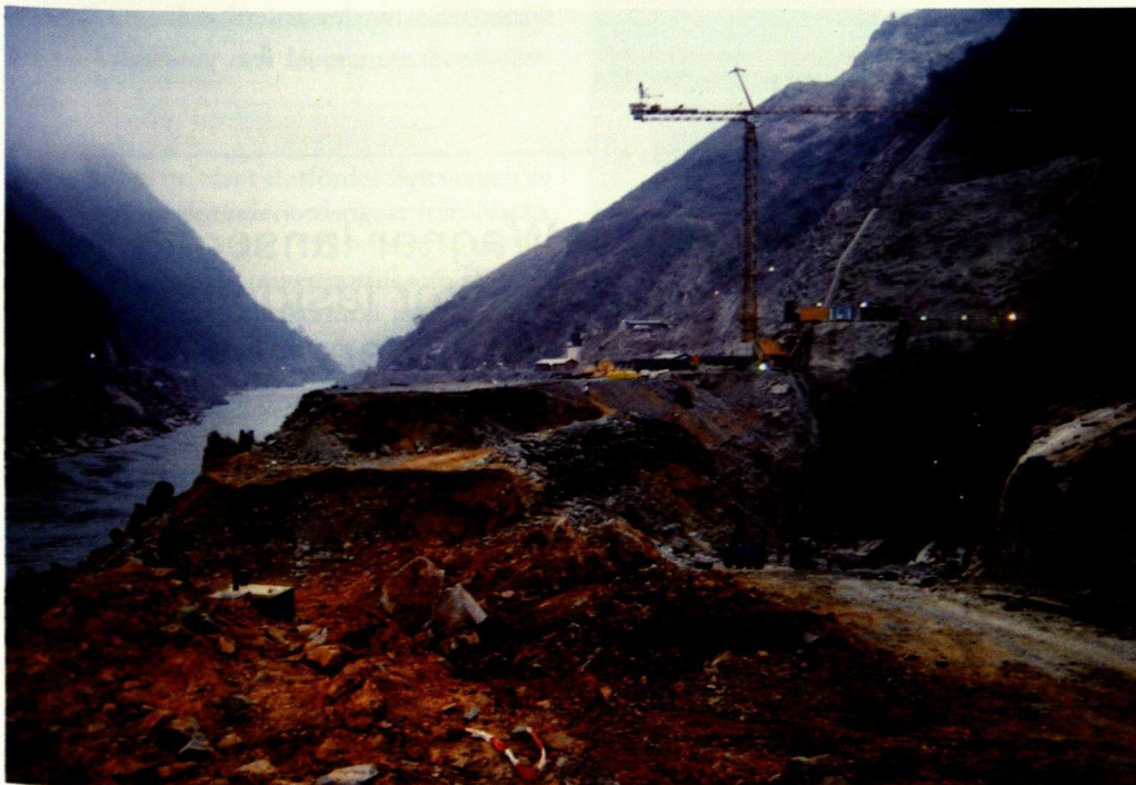
Anläggningsarbeten för Ertans vattenkraftverk i Kina.
