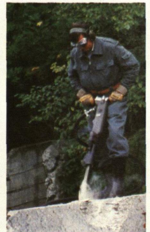
Tryckluftspett i användning inom det schweiziska civilförsvaret.
