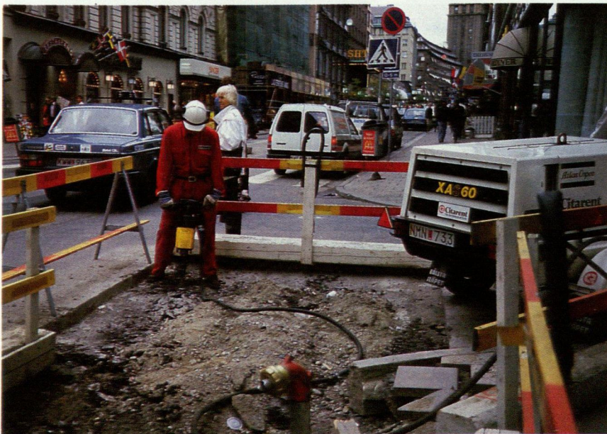
Entreprenörer och kommunala förvaltningar hyr ofta Atlas Copcos ljuddämpade kompressorer för reparationsarbeten.
