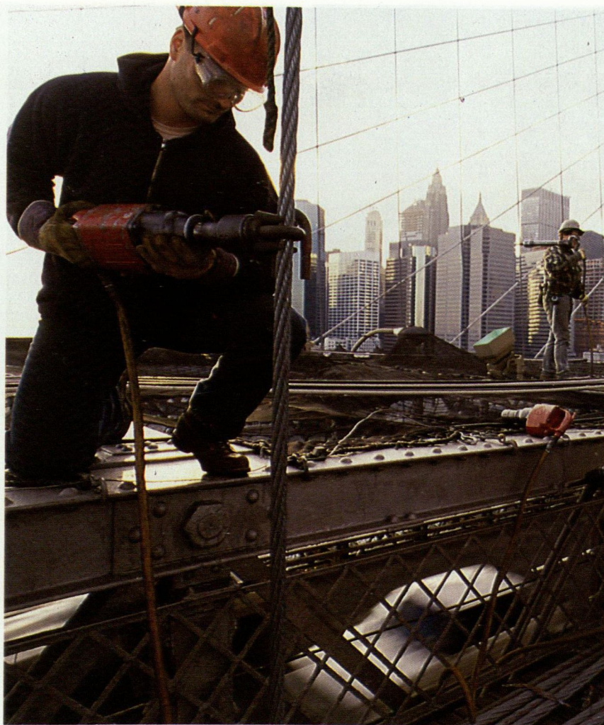
Vid reparation av New Yorks broar används ett flertal olika typer av Chicago Pneumatics tryckluftverktyg. Bilden är tagen från Brooklyn Bridge.
