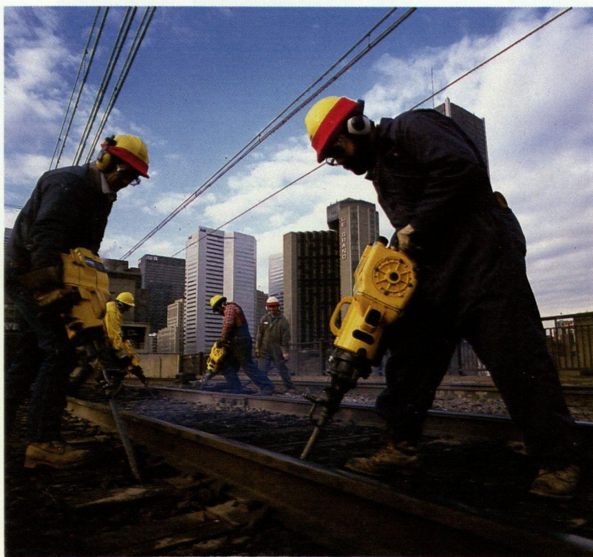
Canadas järnvägsbolag CNR använder regelbundet motorbormaskinen Pionjär för sylpackning.
