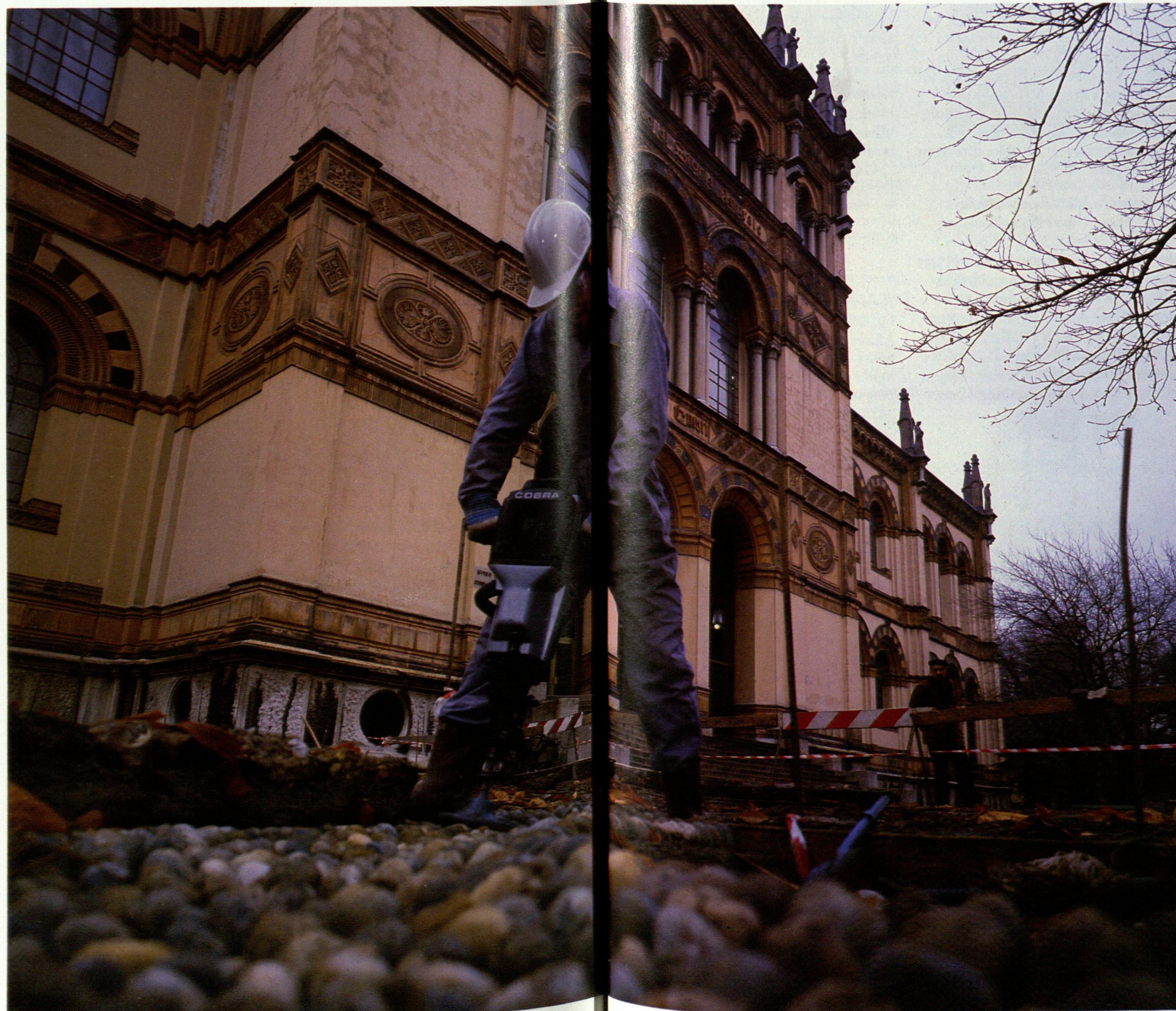
Den bensindrivna bärbara bormaskinen COBRA kan användas för bergbormning, spettning, syllpackning, grävning etc. På bilden används en COBRA för sättning av gatan i Milano, Italien.
