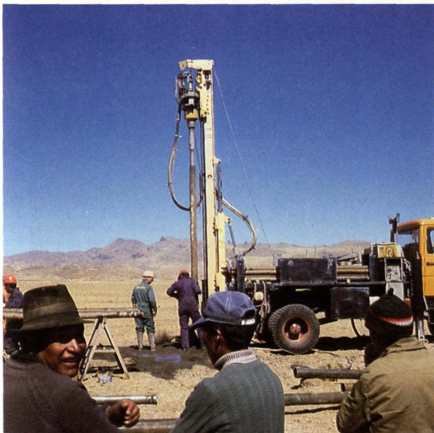
Ett mycket intressant biståndsprojekt, som initierats av Atlas Copco-anställda i samarbete med Rädda Barnen, genomförs fn i Punodistriktet i Peru. Mer än 100 brunnar borrades mellan maj och oktober 1986 för att förse ca 25 000 människor med rent dricksvatten. Brunnsborrningsriggen har levererats av Atlas Copco Energy.
