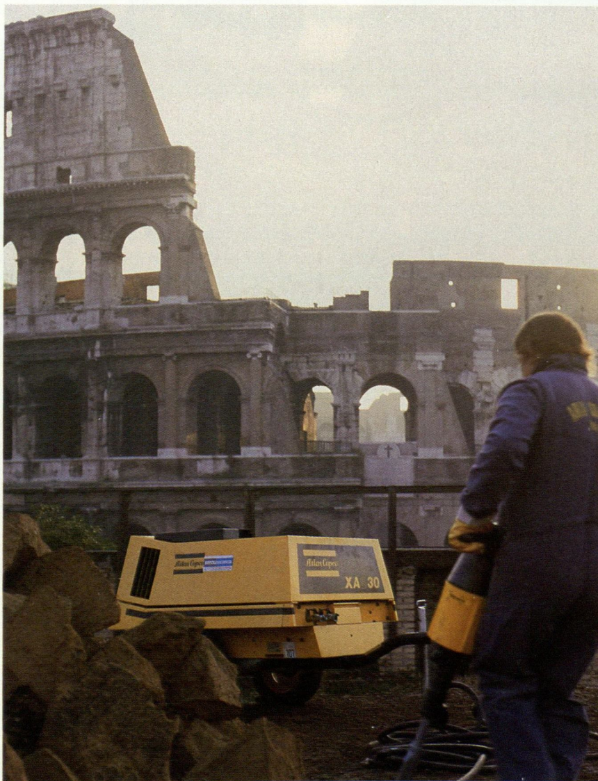
Den nya serien tryckluftspett i TEX-serien har rönt stor efterfrågan. På bilden ses ett av de ljuddämpade TEX-spett som används vid restaureringen av Colosseum.
