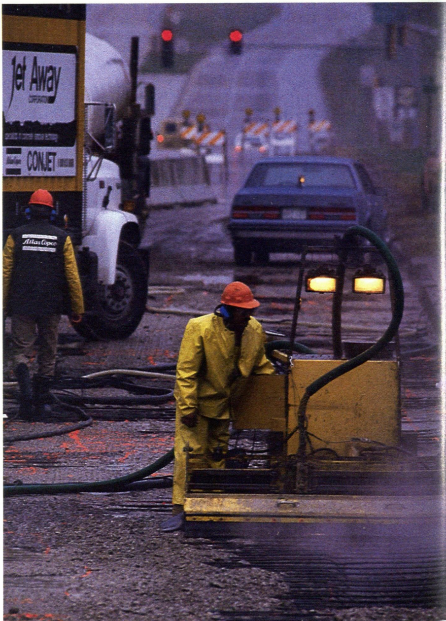
Conjet är ett nyutvecklat aggregat för avlägsnande av skadad och sliten betongbeläggning på broar, vägar, flygfält, parkeringsbus etc. Conjet arbetar med vatten under högt tryck (200 bar) som snabbt avlägsnar den skadade betongen och samtidigt rengör underlaget för den nya beläggningen.
