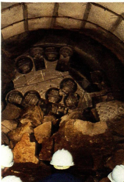
Under hösten 1985 bröt en Jarva tunnelborrningsmaskin igenom den 5,4 km långa kraftverkstunneln i Sand Bar, USA. Arbetet tog 144 dagar och som mest borrades 67 meter på en dag.
