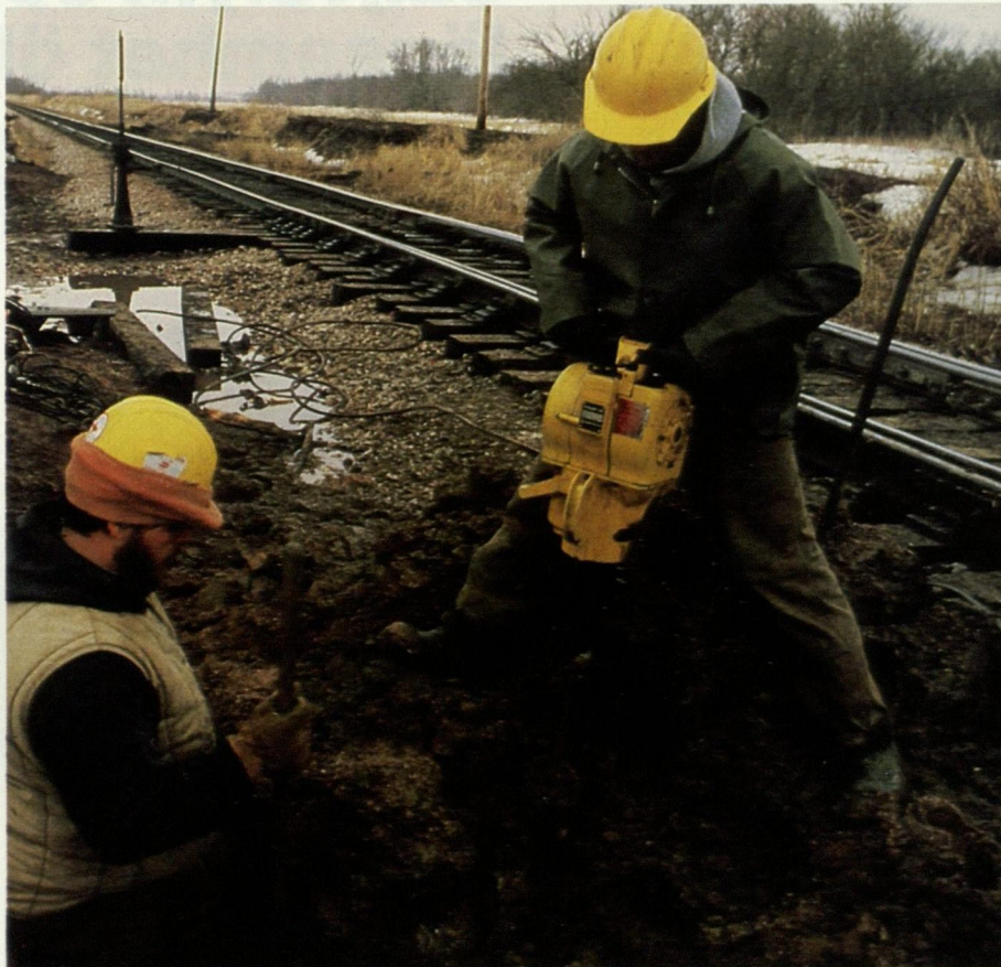
Den bensindrivna, bärbara kombinationsmaskinen Pionjär används för bergborring, spettning, syllpackning, grävning etc. Här används en Pionjär för grävning av en kabelgrav vid ett amerikanskt järnvägsföretag.
