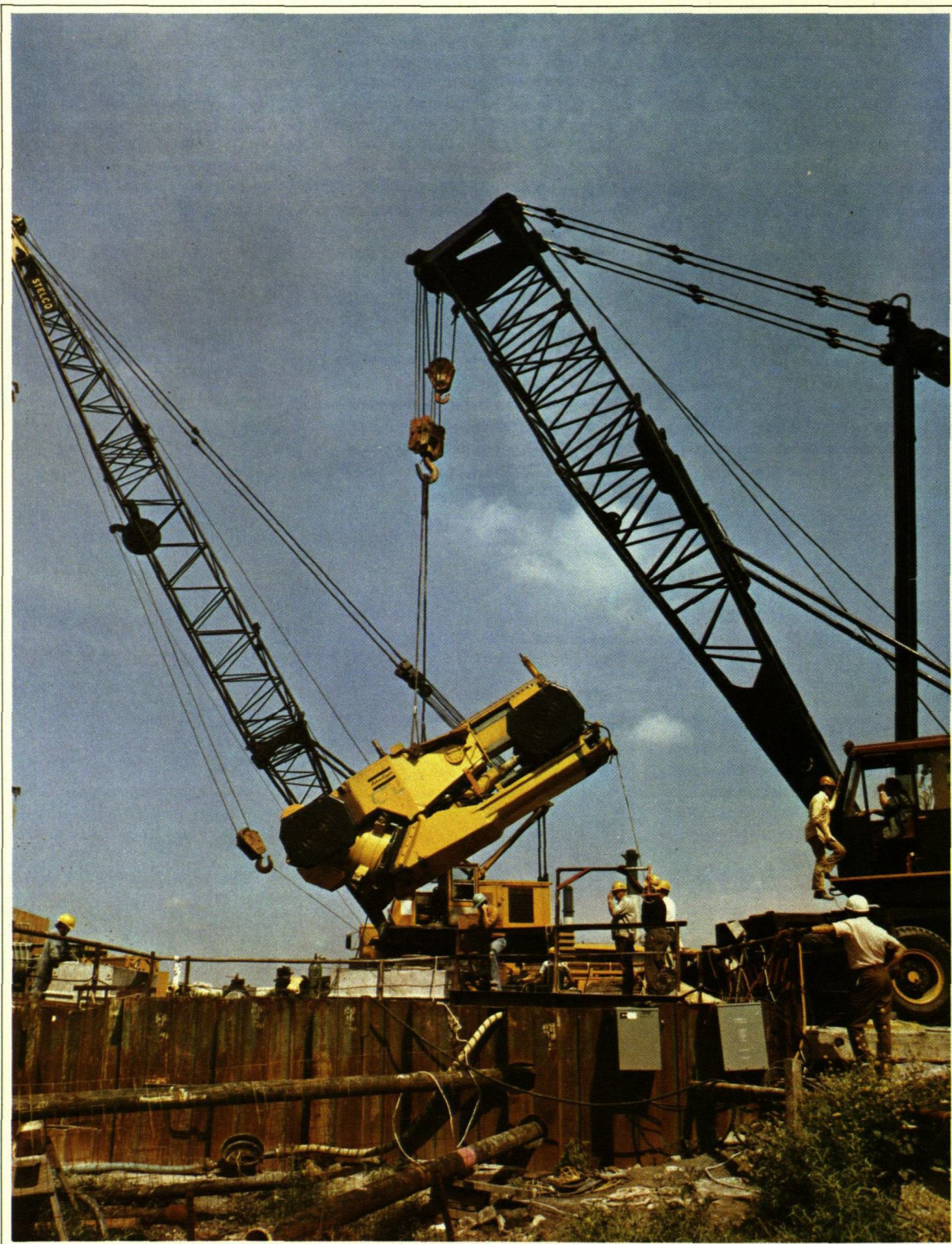
Det nya fullortsborrningsaggregatet Midi Fullface firas ner i sitt schakt för att borra en tunnel under Niagaraflo den för staden Buffalos dricksvattenförsörjning. Entreprenören rapporterar en kostnadsbesparing på nästan en halv miljon dollar i jämförelse med konventionell borrhning och sprängning.
