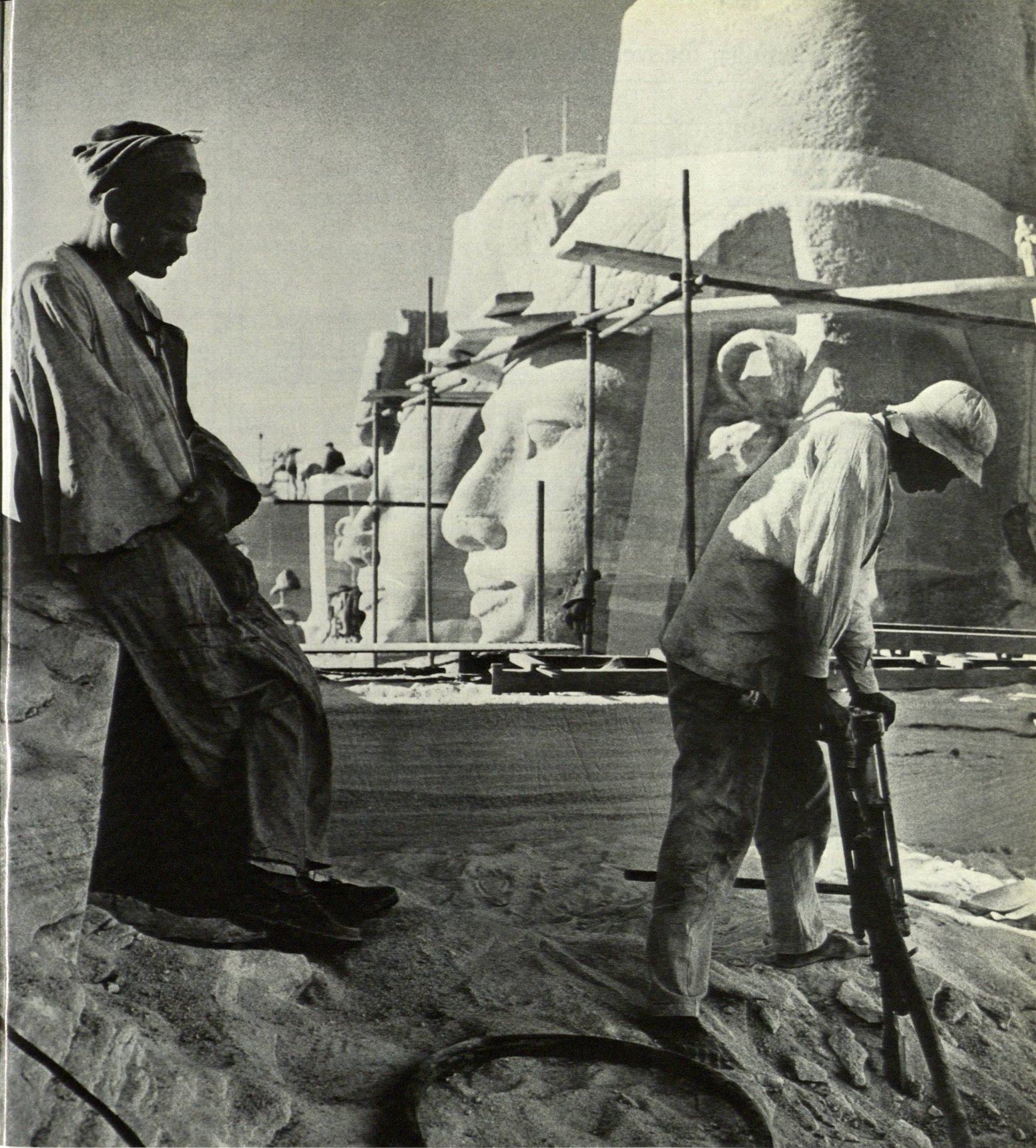
De 3.200-åriga Abu Simbel-templen vid Nilens strand tilldrar sig största intresset av de många nubiska minnesmärken som räddas undan den nya Assuandammens väldiga vattenmassor. Räddningsaktionen utförs av ett internationellt konsortium, och Atlas Copco har levererat mycket av den utrustning — bl. a. tryckluftspett — som används i arbetet.
